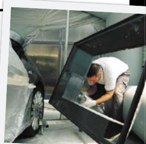
13 Viene montato l'aspiratore
